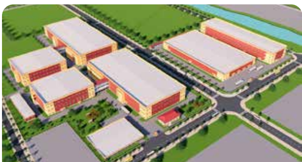
NHÀ MÁY MAY WORLDON GIAI ĐOẠN 5 - CỬ CHI
