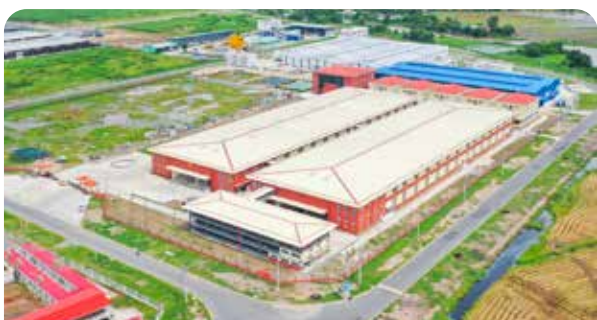
NHÀ MÁY MAY ZHAOWEN KNITTING GIAI ĐOẠN 1 - TÂY NINH
