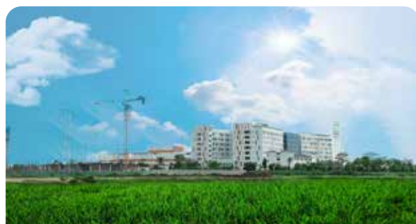
XÂY MỚI TRUNG TÂM XÉT NGHIỆM Y KHOA – BÌNH CHÁNH
