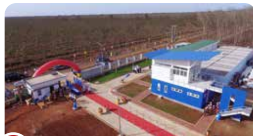
22 Nhà Máy Nước Chư Sê – Gia Lai
