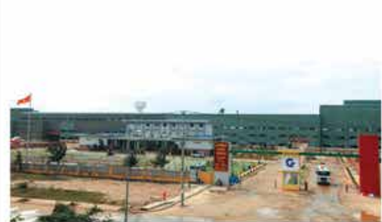
NHÀ MÁY KÍNH NỔI CHU LẠI - QUẢNG NGÃI
