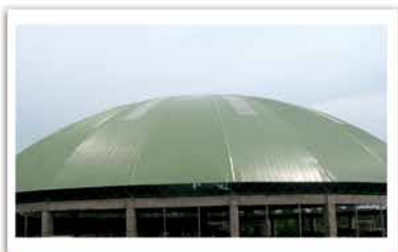
NHÀ MÁY XI MĂNG - BÌNH PHƯỚC
