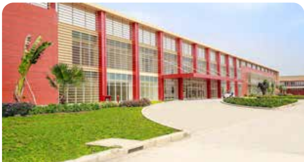
NHÀ MÁY MAY WORLDON GIAI ĐOẠN 5 - CỬ CHI
